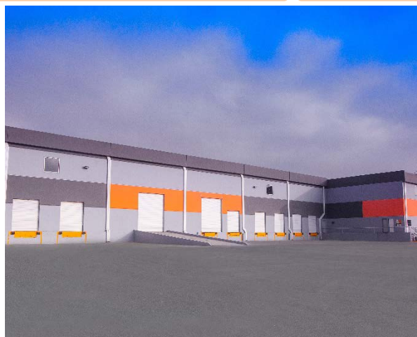
MTY017 Monterrey, Nuevo León
