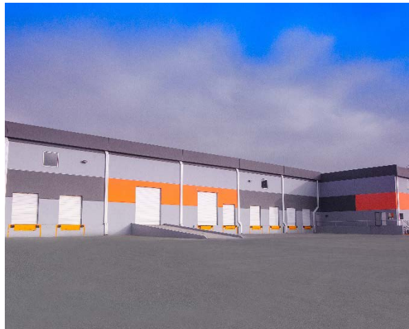
MTY017 Monterrey, Nuevo León
