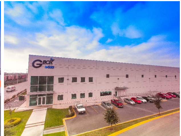
MTY036 Monterrey, Nuevo León
